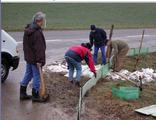
Der unermüdliche Einsatz der Helfer beim Bau des Amphibienzauns ermöglicht vielen Tieren die Wanderung zum Laichgewässer.
